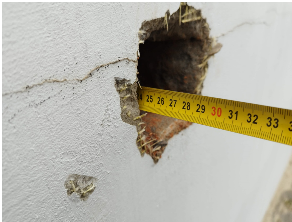
Fotografia nr 2 Pomiar grubości ściany w miejscu odkrywki
