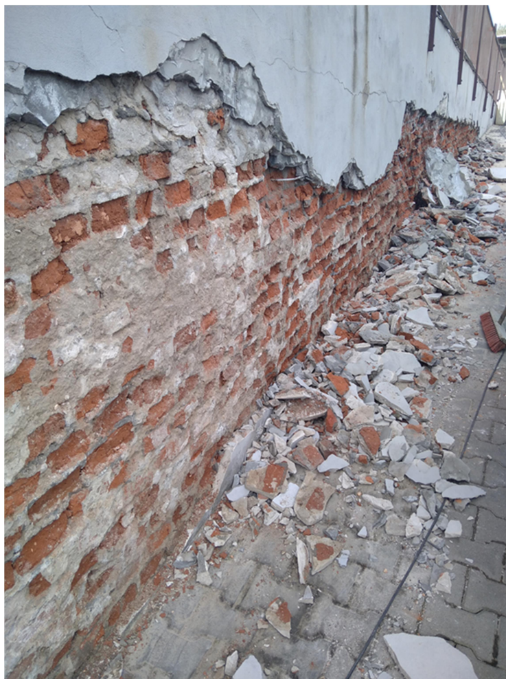
Fotografia nr 3 Mur pod zjazdem przed naprawą tynku (zdjęcie archiw. TSM Oskard z 2.05.2023 r.)
